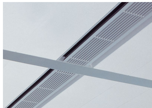
Klimatelement in OWA-Bandrasterdecke integriert
