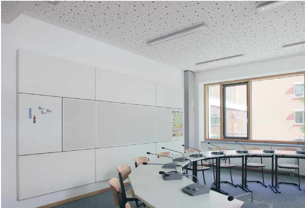
Fotos: OWA GK-Decke nicht ausreichend. Mit nachträglich installierten Breitband- und Tiefenabsorbern an den Wänden konnten die erforderlichen Nachhallzeiten erzielt werden.
